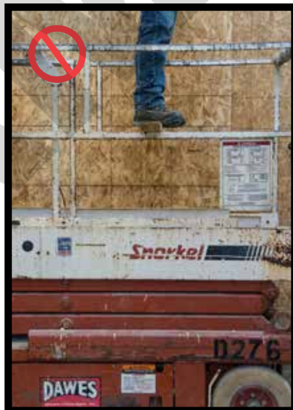
Do not use planks to increase the platform height. No usar tablas para aumentar la altura de la plataforma.
