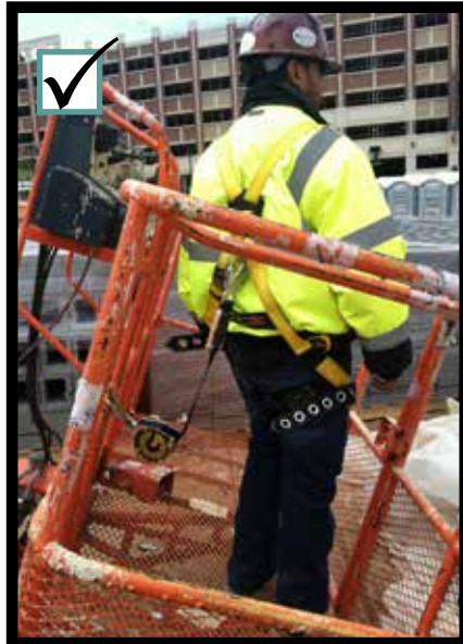
Use a personal fall arrest system. Usar el sistema de detención de caídas.
